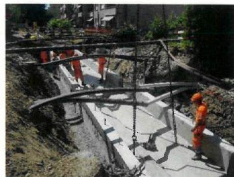
Einbau Bachdurchlass Lyssachsachen
