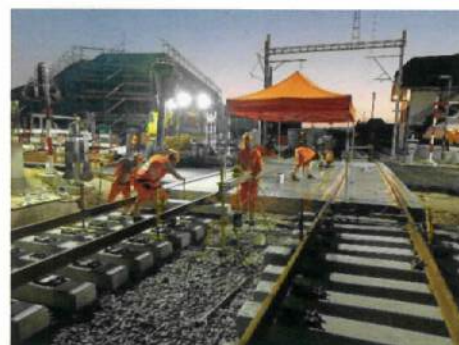
Einbau Bahnübergang Staatsstrasse
